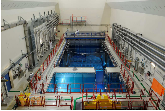
Fig. 4: Kernkraftwerk Gösgen-Däniken AG © –Fuel pool
