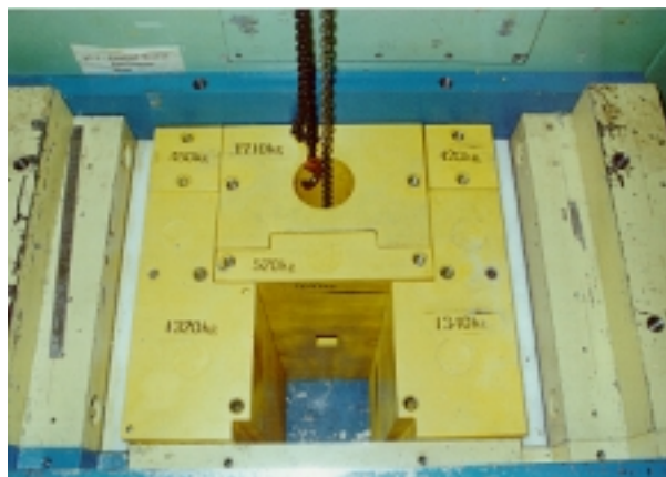
사진 3. Collimator 주변 차폐체 설치.
