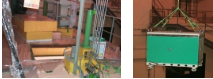
그림 7. 핫셀 천장도어 개방 및 해체폐기물 반출.
