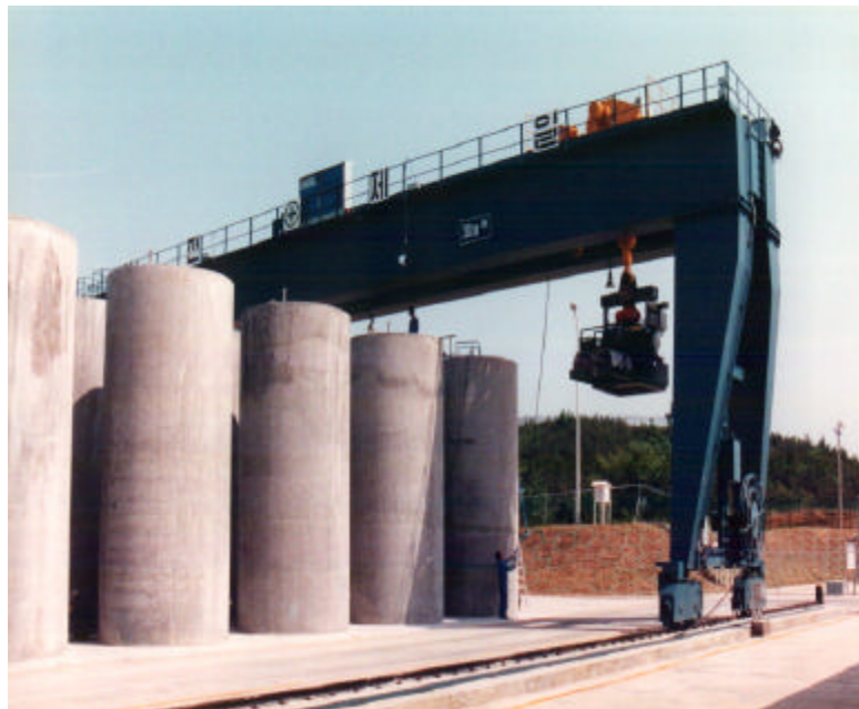
그림 1. 현재 월성에서 운영중인 Concrete Silo 방식의 건식저장시설
