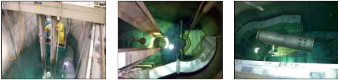
그림 2-5 Support channel에 의해 연결된 브릿지와 노심, 분리된 노심
