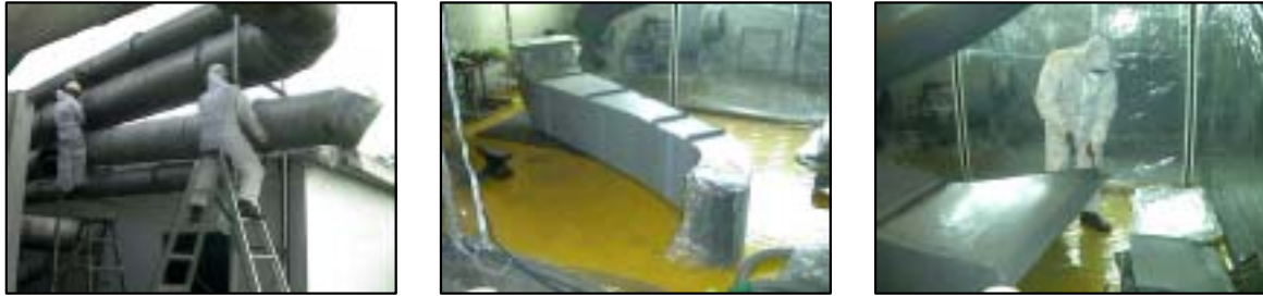
그림 2-14 Green house 내와 옥외의 Duct 해체 작업 및 세절작업
