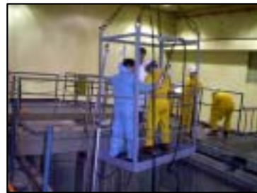
그림 2-1 주변물품 제염작업 및 제작된 작업용 Bucket
