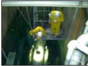
그림 2-7 노심의 상, 하부 Shroud 분리 과정
