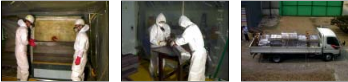
그림 2-12 수평차폐도어, 수평T/C 내부, Green house 및 Graphite 해체, 포장, 이송
