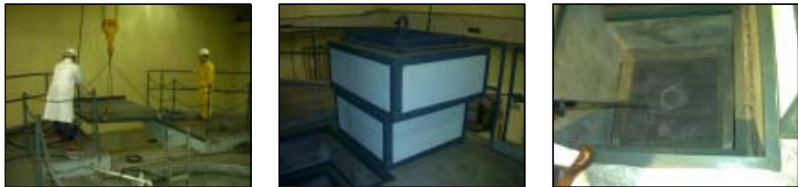
그림 2-11 상부 plate, 수직차폐도어, 수직 T/C내부 및 스틸 Box 내 Graphite
