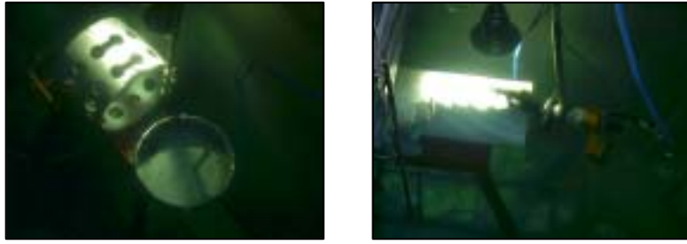
그림 2-8 원격 Cutting tool 및 유압절단기를 이용한 노심의 세절작업
