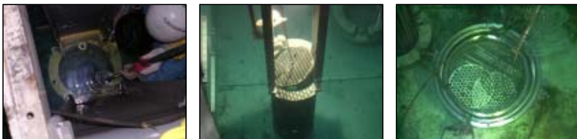
그림 2-6 Grid의 set bolt 제거, 인출 및 저장
