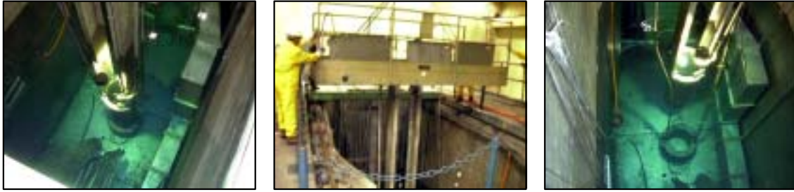
그림 2-2 RSR과 노심분리 전, 브릿지 상향인양, 노심분리 후
