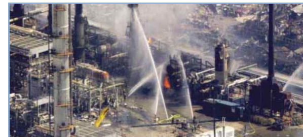
미국 텍사스 정유공장 밸브 오작동 및 인적실수에 따른 폭발사고
