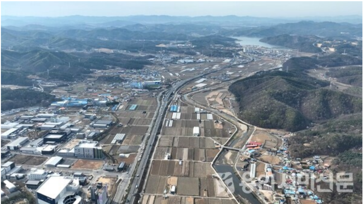
용인 첨단 시스템 반도체 국가산단이 들어설 이동 남사읍 일대 전경. 중앙을 관통하는 도로가 국도 45호선
