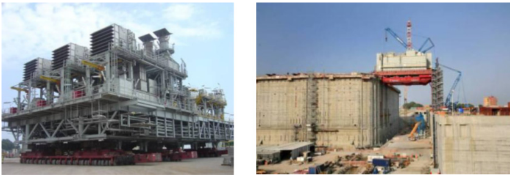
그림 2.3-3 중력식 구조물에 LNG 관련 설비를 설치 과정
